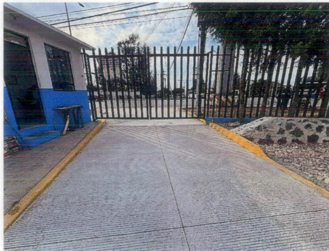
Fig. 3. Acceso PTAR ACUAPUE
