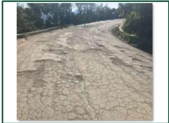
*Imagen 7: Tramo Zacapoaxtla - Huahuaxtla, con severos daños en la superficie de rodadura.*
