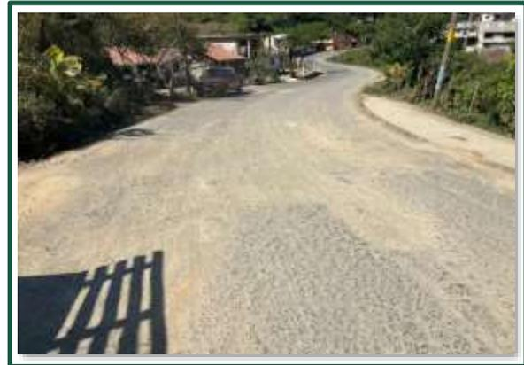
*Imagen 9: Tramo Huahuaxtla - Equimita, observándose agrietamientos ocasionados por la humedad bajo el pavimento, con fallas en la subrasante, sub-base y base.*
