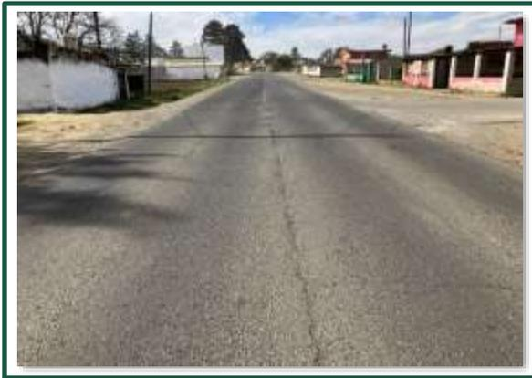
*Imagen 6: Tramo Acuaco – Zacapoaxtla, con presencia de “acodrilamiento” en la superficie de rodadura, aunado a que no se cuenta con señalamiento horizontal.*
