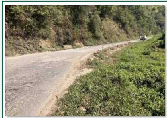
*Imagen 8: Tramo Huahuaxtla - Equimita, el cual presenta erosión de la carpeta asfáltica, así como de las cunetas, ocasionando que se estanque el agua en la vía.*
